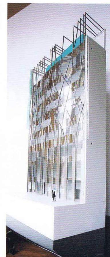
DO SEGUNDO PAVIMENTO ATÉ O CORDAMENTO DO EDIFÍCIO, AS LÂMINAS DESCREVEM CURVAS, FORMANDO UMA TRAMA SOBREPOSTA À PRIMEIRA CAMADA (ESTUDO EM MAQUETE)
