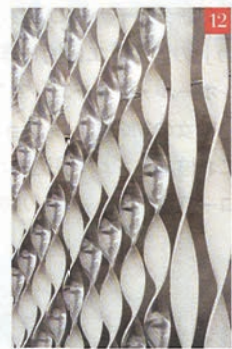
10. ルイ・ヴィトン ナゴヤ ミッドランド スクエア店外観。ミッドランド スクエア最南端に、同施設内最大面積で出店。高さ11mのファサードに様々なツイストをかけたバー約600本が並び、ダミエパターンを作る 11. ウィンドーディスプレイを埋め尽くすヘッドライト 12. ファサードに並ぶツイストバーはねじれが様々で、片面がシルバーに磨かれたものもある
